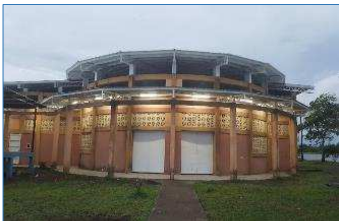
Apreciar vista panorámica del Polideportivo Alexis Arguello, en la fotografía a la izquierda situación sin proyecto, a la derecha situación con proyecto finalizado. Se observa la instalación de ventanas metálicas tipo louvers y pintura en paredes.
