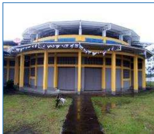
Apreciar vista panorámica del Polideportivo Alexis Arguello, en la fotografía a la izquierda situación sin proyecto, a la derecha situación con proyecto finalizado. Se observa la instalación de ventanas metálicas tipo louvers y pintura en paredes.
